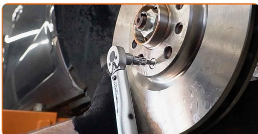
Remplacement : roulement de roue – ALFA ROMEO Brera (939\_). Les experts d'AUTODOC recommandent :
