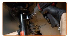
Serrez les fixations inférieures qui relient l'amortisseur à la fusée d'essieu. Utilisez une douille n° 18. Utilisez une clé dynamométrique. Serrez-le jusqu'à 70 Nm.+90°
