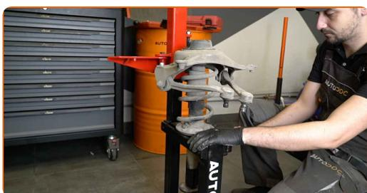
Remplacement : jambe de suspension – AUDI A4 B8 Avant (8K5). Les experts d'AUTODOC recommandent :
