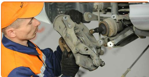
Remplacement : roulement de roue – Mercedes W211. AUTODOC recommande :
