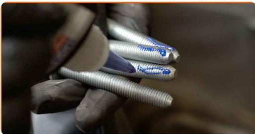
**92** Installez les boulons de fixation.
