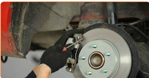
**49** Appliquez du produit sur la zone de contact entre le disque de frein et la jante. Utilisez de la graisse au cuivre.
