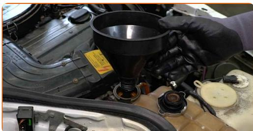
**27** Versez du liquide de refroidissement dans le réservoir.
