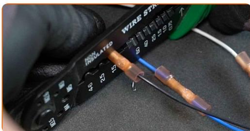
**17** Rétractez les gaines thermorétractables des manchons à souder. Utilisez un pistolet thermique.
